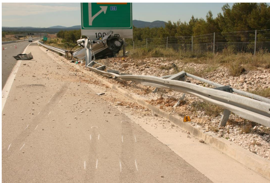
Slika 13 – Prikazuje nalet vozila na željeznu ogradu i posljedice naleta
