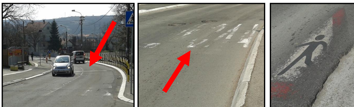
Слика бр. 2 – Приказ стања хоризонталне саобраћајне сигнализације
